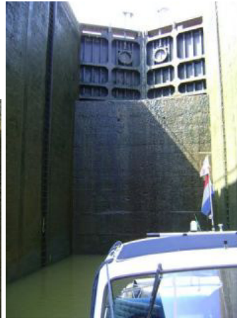
Laatste sluis in de kanalen, verval 14 mtr.
