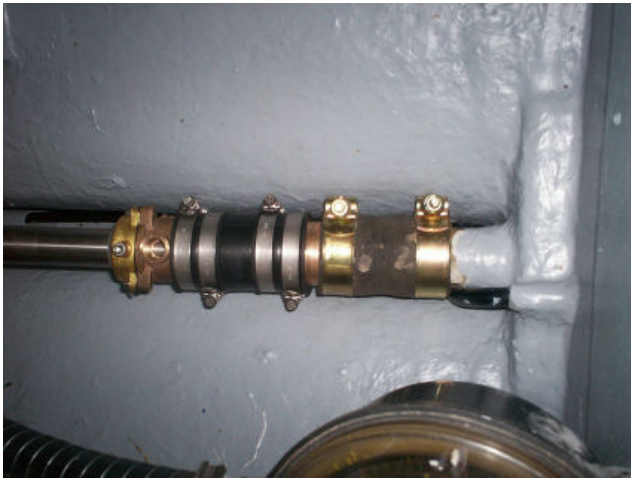
foto 15: De gehele nieuwe installatie
