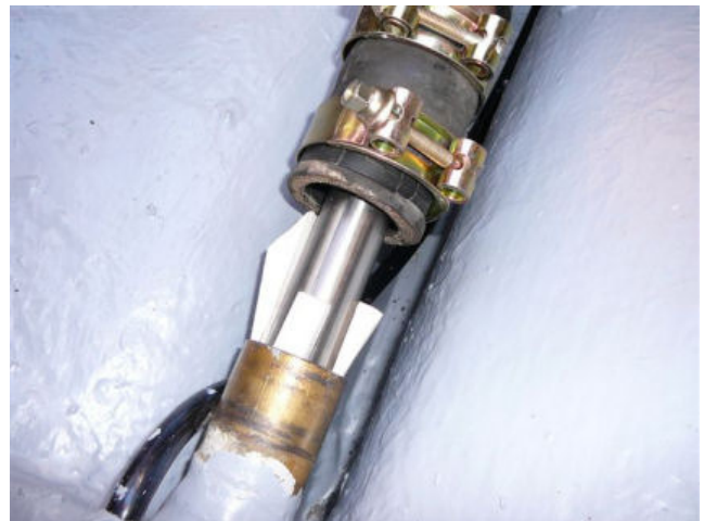
foto 14: Het centreren van de schroefas in de koker.
