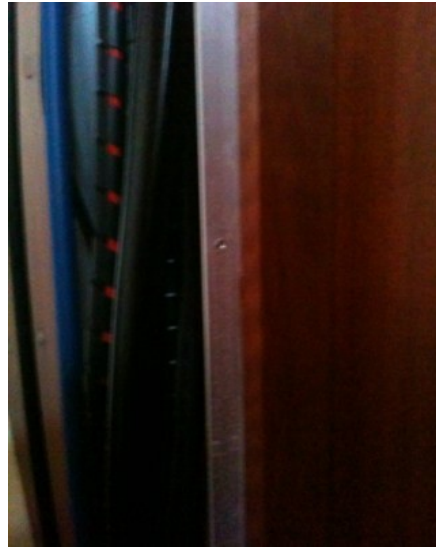
Detail van de uitstekende alu/hoeklijn incl. bevestigingsgaatje voor de afdekkap
